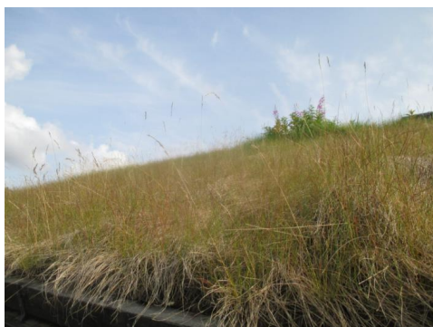
Deler av taktekkingen.
