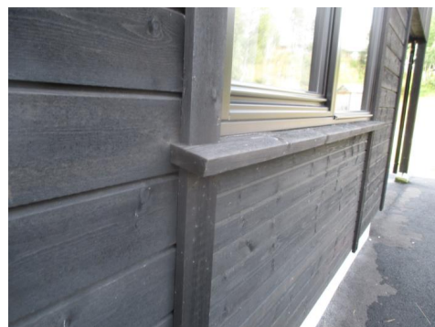
Deler av kledningen med tilhørende belistninger.
