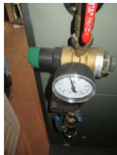
Innvendig stoppekran med vannmåler.
