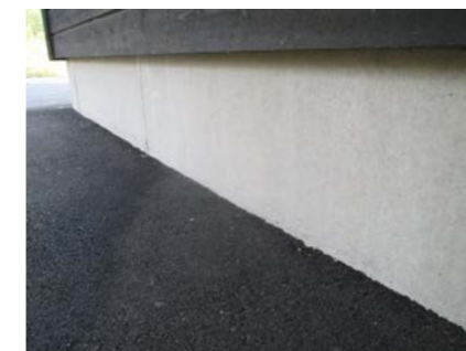
Deler av ringmur.
