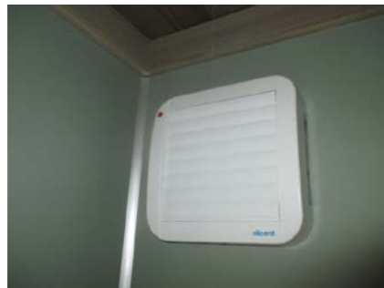
Vifte i ytterveggen på bad/vaskerom.
