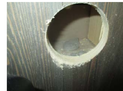
Hulltaking i trappeoppgangen.
