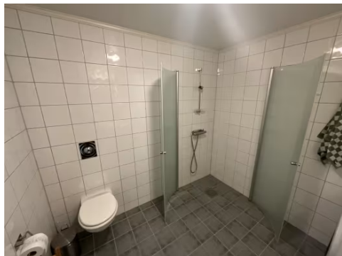
Innfellbare dusjdører, veggmontert termostattbatteri og dusjgarnityr. Veggmontert toalett med innebygget systerne.
