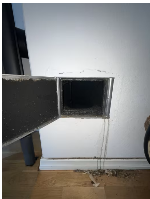
Viser sotluke innvendig.
