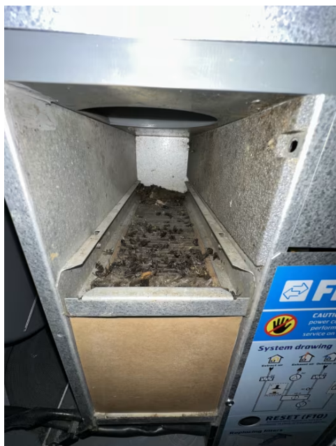
Filter bør skiftets og anlegget må rengjøres.
