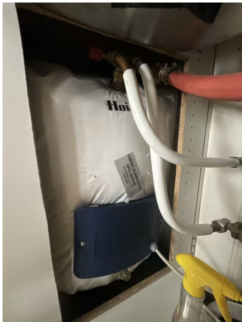
Viser bereder plassert i kjøkkenskap.
