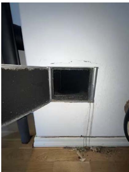
Viser sotluke innvendig.
