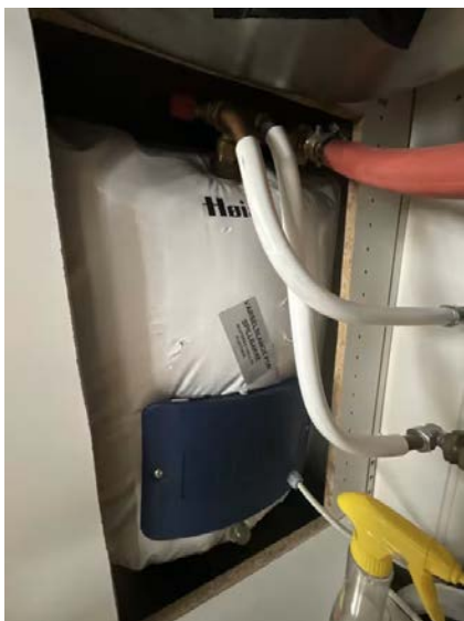
Viser bereder plassert i kjøkkenskap.
