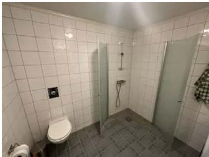
Innfellbare dusjdører, veggmontert termostatbatteri og dusjgarnityr. Veggmontert toalett med innebygget sisterne.
