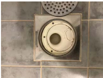
Viser sluk i dusjsonen.
