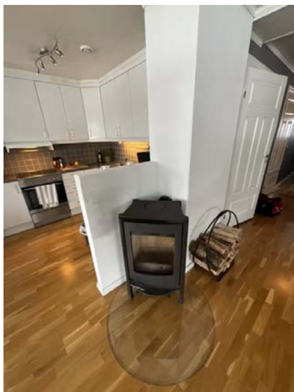
Viser ildsted montert i stue.
