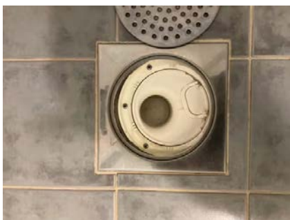
Viser sluk i dusjsonen.
