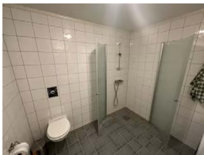
Innfellbare dusjdører, veggmontert termostadbatteri og dusjgarnityr. Veggmontert toalett med innebygget sisterne.
