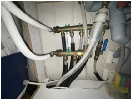
Vannrør med rør i rør system fra åpen fordeler plassert under kum på kjøkken og frem til sanitærinstallasjoner på badet og kjøkken.
