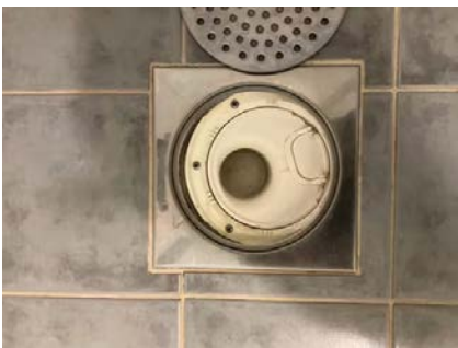
Viser sluk i dusjsonen.
