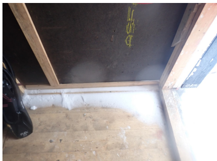
Påvist lekkasjer og påbegynte råteskader i taktro.
