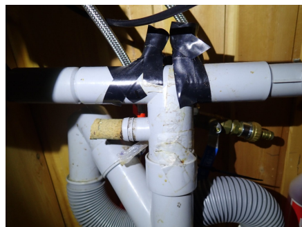
Ufagmessig avløpsløsning.
