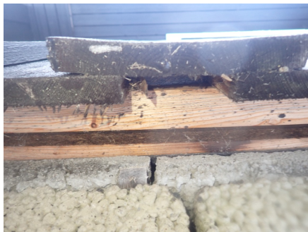
Tetting med museklosser bak kledningsbord på tilbygg.
