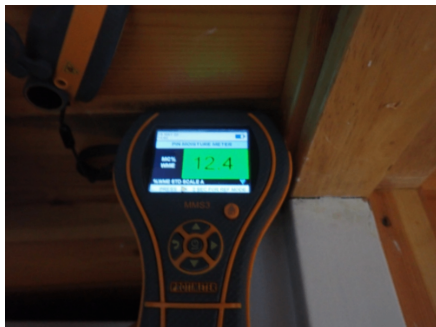
Fuktmåling i kjøkkenet.
