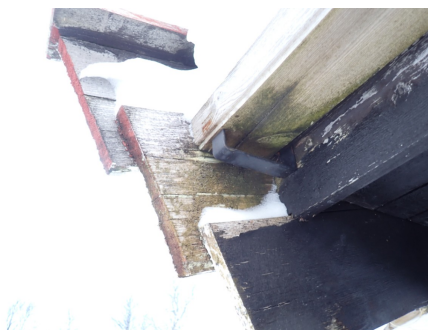
Tegn på utettheter / mosegroing.
