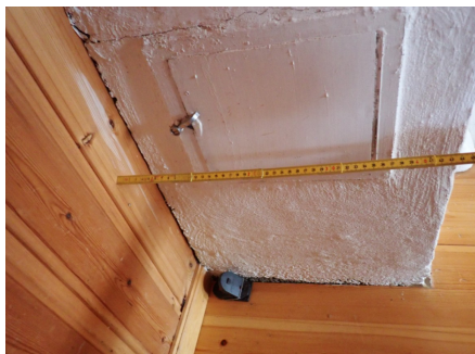
Oversiktsbilde, sotluke. plate under luke.
