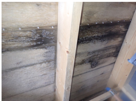
Påvist lekkasjer og påbegynte råteskader i taktro.
