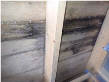
Påvist lekkasjer og påbegynte råteskader i taktro.
