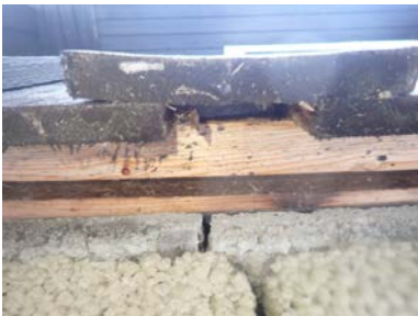
Tetting med museklosser bak kledningsbord på tilbygg.
