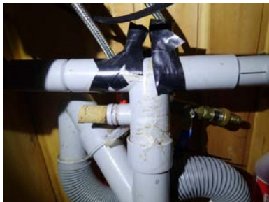
Ufagmessig avløpsløsning.
