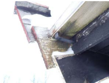
Tegn på utettheter / mosegroing.
