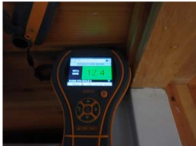
Fuktmåling i kjøkken.
