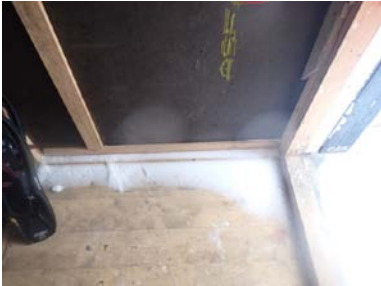
Påvist lekkasjer og påbegynte råteskader i taktro.
