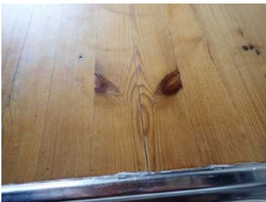
Sprekker i benkeplate.
