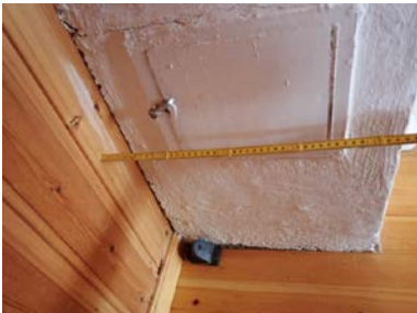
Oversiktsbilde, sotluke. plate under luke.
