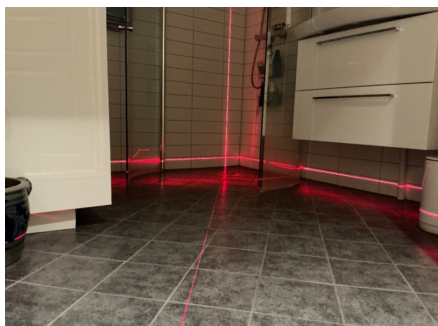
Fall på baderomsgulv er kontrollert med krysslaser.
