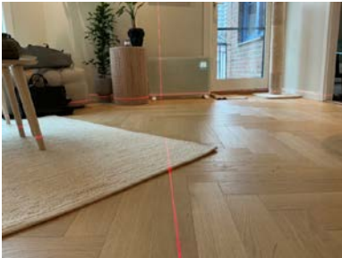
Etasjeskille er kontrollert med krysslaser.
