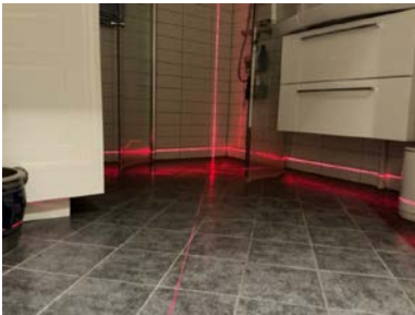
Fall på baderomsgulv er kontrollert med krysslaser.
