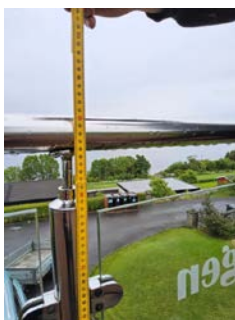
Rekkverket er for lavt i forhold til dagens krav til rekkverkshøyder. Dagens krav er 1 meter, men det er ikke krav om å endre rekkverk til denne høyden.
