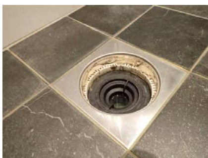
Slukløsning med synlig slukmansjett og
