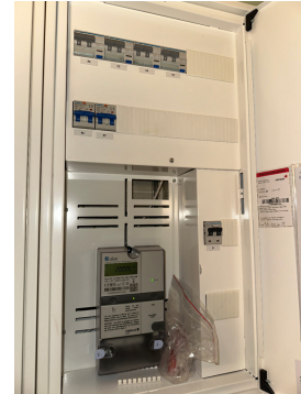
Sikringsskap plassert i felles oppgang.
