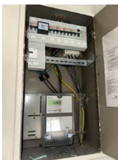
Sikringsskap plassert i felles oppgang.
