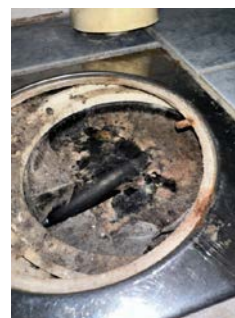
Hovedsluk med klemring for membran
