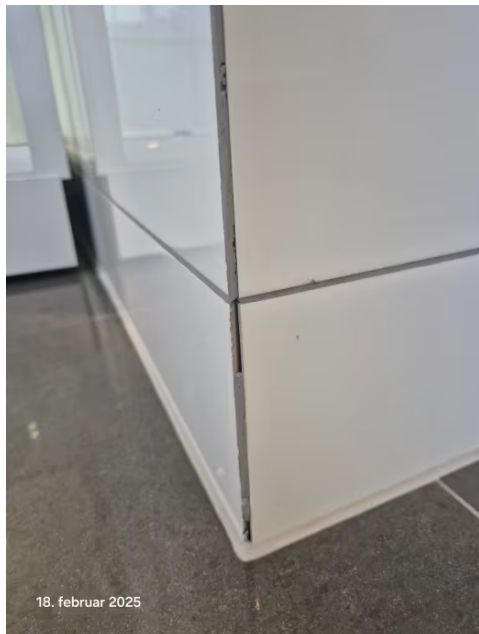
Sprekk i fug på utvendig hjørne.
