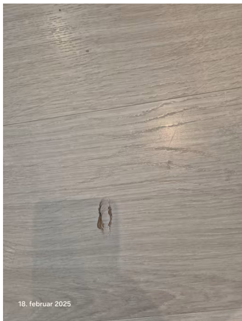
Skade i laminat på kjøkkenet.
