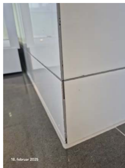
Sprekk i fug på utvendig hjørne.
