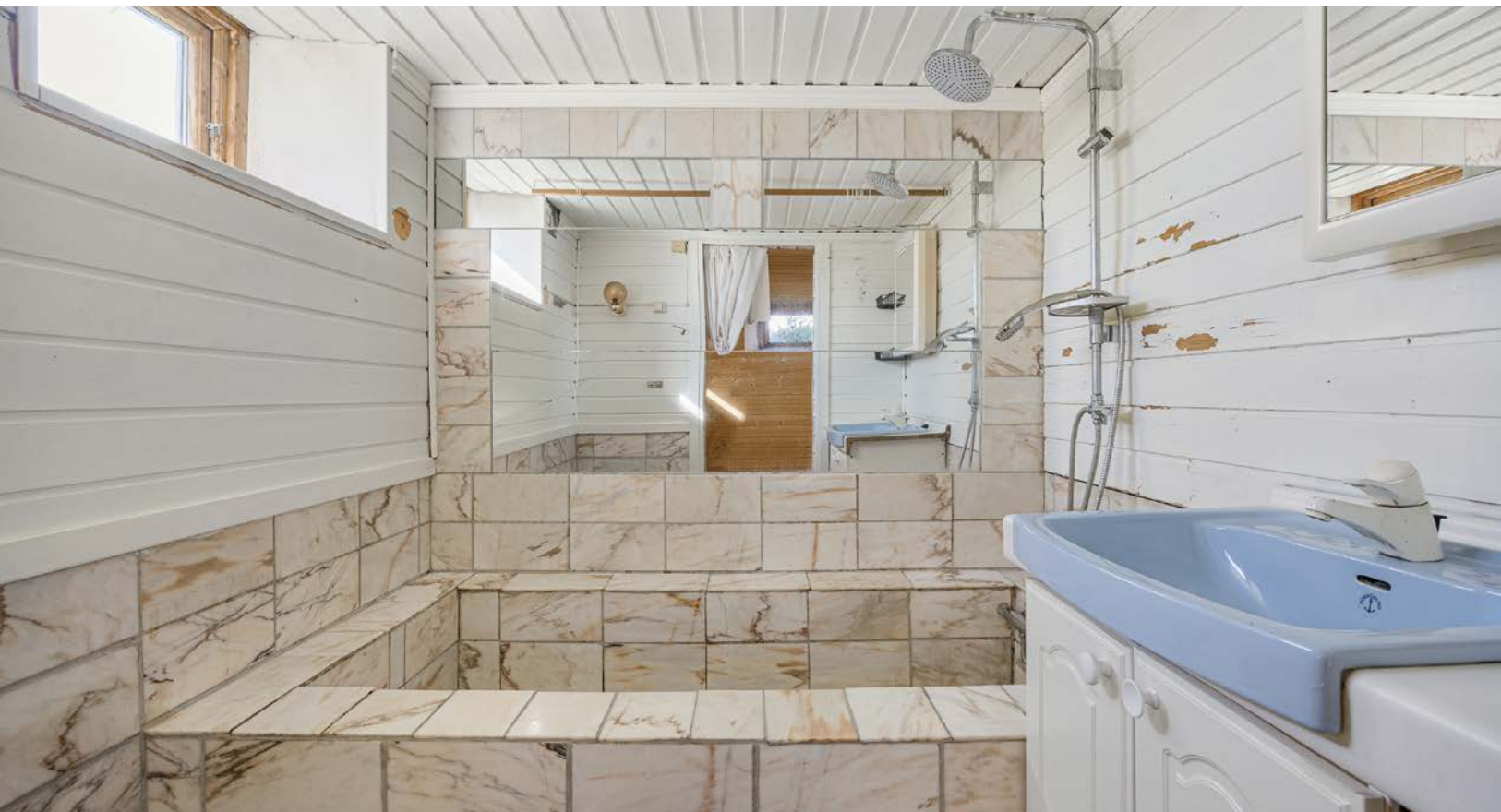
Badet i kjelleren har behov for oppgradering for å oppnå dagens krav til standard. Her er det malt panel og fliser på veggene og fliser på gulv. Rommet har hvit servanttinnredning, speilskap og et innfliset badekar med regnfallsdusj.
