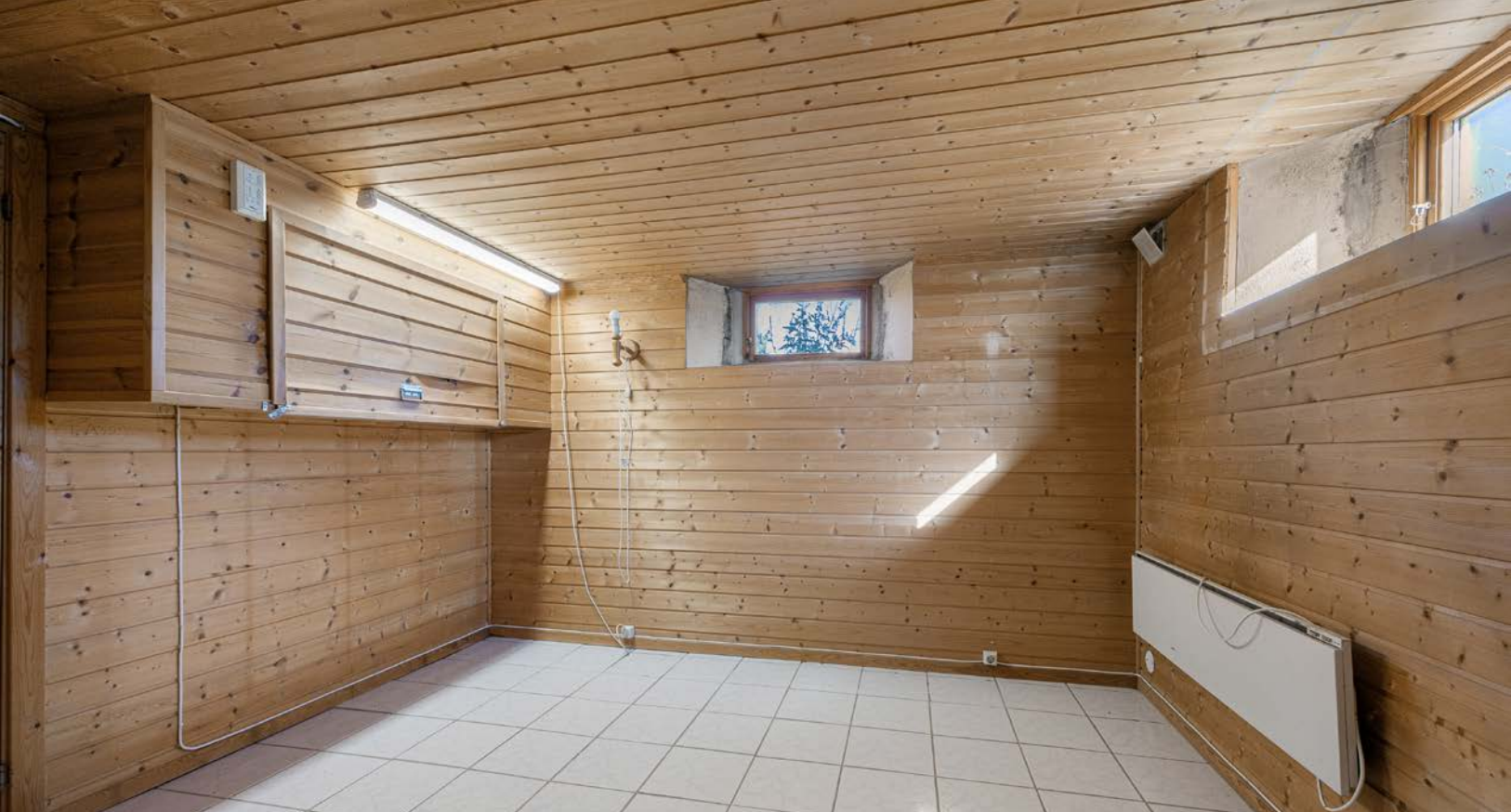
Innredet rom i kjeller. Rommet er ikke godkjent brukt som oppholdsrom.
