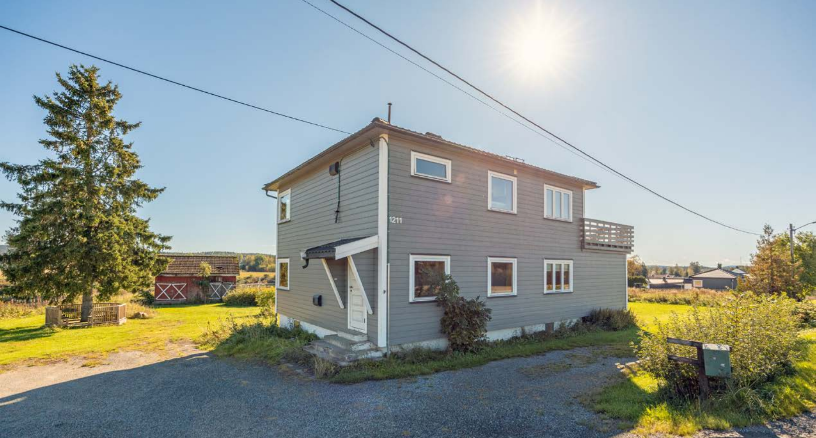
Tomannsboligen har et pent, felles og overbygd inngangsparti med asfaltert adkomst, støpt, buet trapp og takmontert utebelysning.
