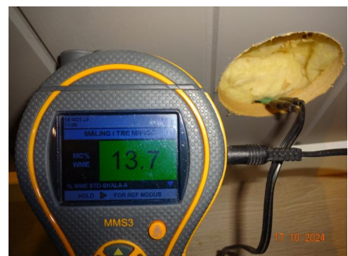
Fuktmåling i bunnsvill.
