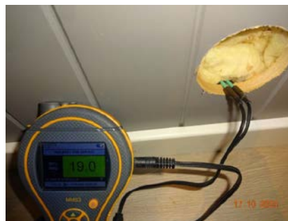
Fuktmåling i kjelleryttervegg.
