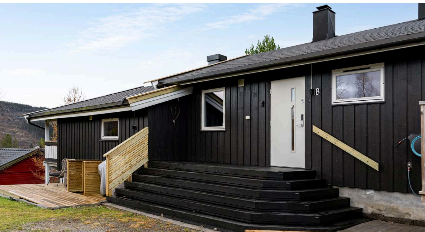
En stor, lys og innbydende del av tomannsbolig som føles som en enebolig. Boligen ble tilbygget i 1994 og vesentlig oppusset i 2019.
