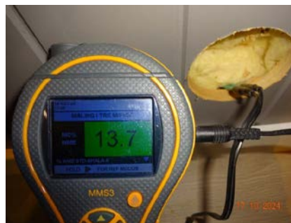
Fuktmåling i bunnsvill.
