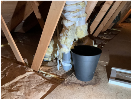
Eldre merker, ny pipehatt er montert.
