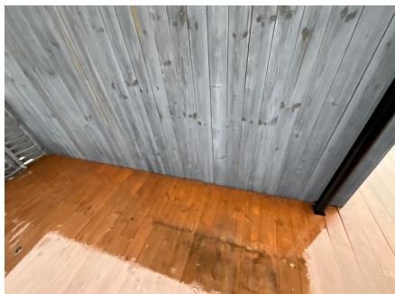
Kledning montert helt inn mot terrassen.
