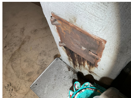
Sotrenn under luke på loftet.
