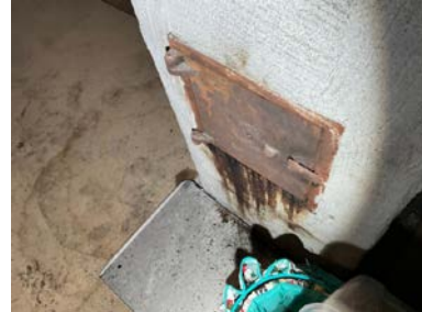
Sotrenn under luke på loftet.
