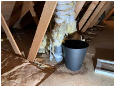
Eldre merker, ny pipehatt er montert.
