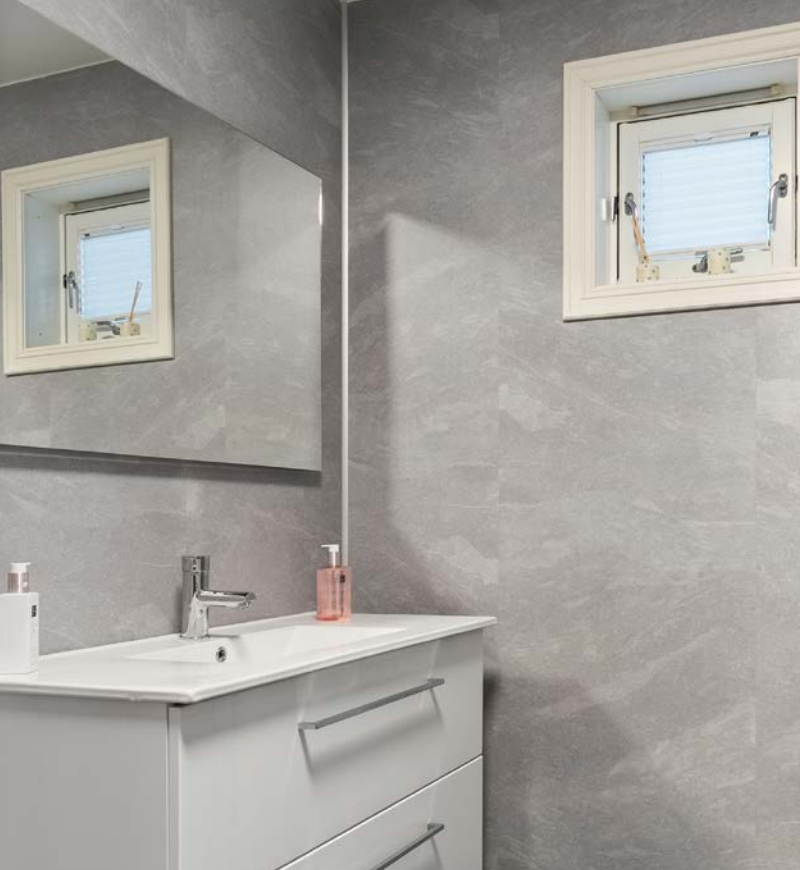
Bad/vaskerom med belegg på gulv og høytrykks laminerte våtroms plater
