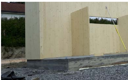
Foto 1. Foto mottatt fra Svein Aaserud som viser en hytte under oppføring. Det er støpt plate på mark, og KLT-elementene i ytterveggene er montert på støpen med litt overheng på utvendig side.
