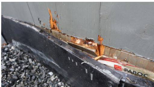
Foto 8. Daskerudvegen 50, østvegg. Her er trevirket nedbrutt ca. 4 cm inn i veggen, dvs. at de to ytre lamellene er berørt. Beslaget ble løsnet fra veggen, og man ser hvordan det er slisset inn i ytre lamell i KLT-elementet. Overgangen mellom KLT og betong er tapet.
