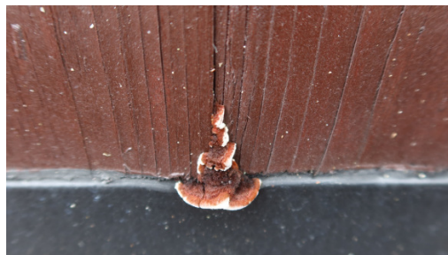
Foto 9. Daskerudvegen 90, sørvegg. Fruktleger av vedmusling. Skaden berører trolig de to ytre lamellene.
