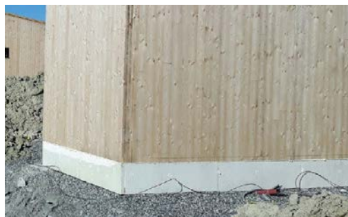
Foto 2. Foto mottatt fra Svein Aaserud som viser en hytte under oppføring. Det er lagt isolasjonsplater som kuldebryter utvendig på den støpte sålen.
