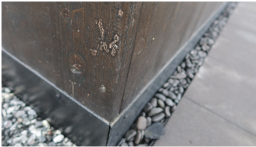
Foto 3. Det er slisset inn et beslag i nedre del av massivtreplatene på veggen. Beslaget står vinkelrett inn i veggen og dekker overgangen mellom platene og isolasjonen rundt støpen de står på. Denne hytta er fra byggetrinn 2 eller 3 og har et bord som dekker endekanten av veggplatene i hjørneskjøten.
