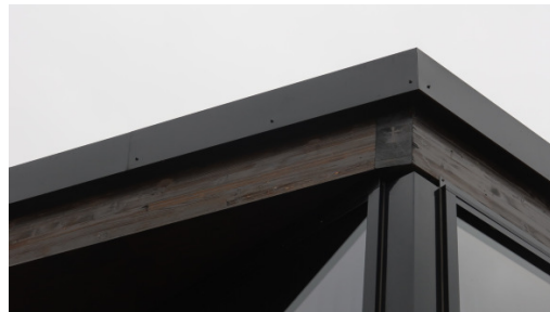
Foto 5. Byggetrinn 2 og 3 har en stålsøyle i hjørnet mellom sørvinduet og vinduet på vest- eller østvegg. Skjøt mellom veggelementer i KLT opp mot taket er utildekket.
