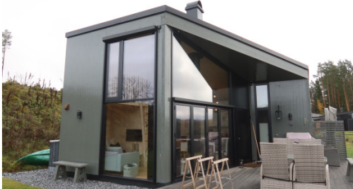
Foto 4. Oversikt over hytte fra byggetrinn 1. Denne hytta har den skrå delen av grunnrisset vendt mot sørvest, dvs. at den har et stort vindu på vestveggen. Alle hyttene har et stort vindu mot sør som er delvis tildekket av takutstikk over terrassen. Byggetrinn 1 og har KLT mellom sørvinduet og vestvinduet.
