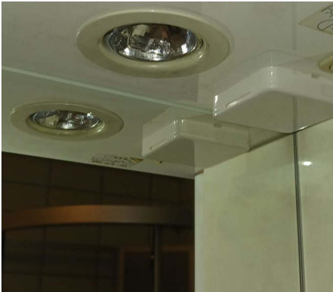
Bilde 1 Beskyttelse glass mangler på spott.
