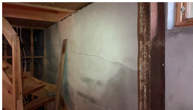
Sorekker i mur og avskalling av puss
