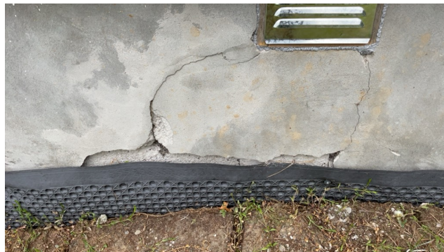
Sorekker i mur og avskalling av puss
