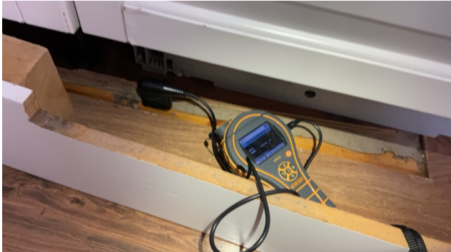
Ved fuktmåletsking av gulv under oppvaskmaskin var det ikke fuktutslag
