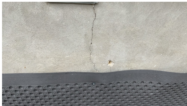
Sprekk i mur
