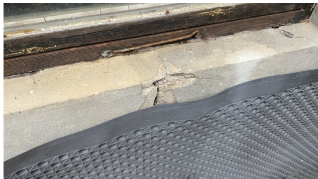
Sprekk i mur
