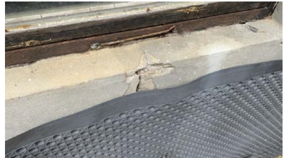
Sprekk i mur
