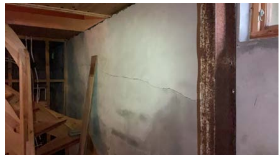
Sorekker i mur og avskalling av puss
