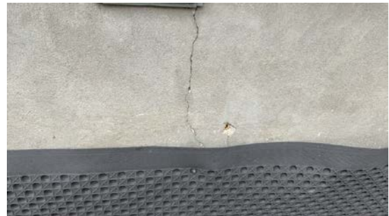
Sprekk i mur
