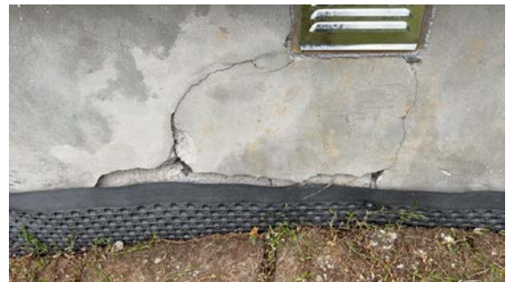
Sorekker i mur og avskalling av puss
