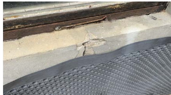
Sprekk i mur
