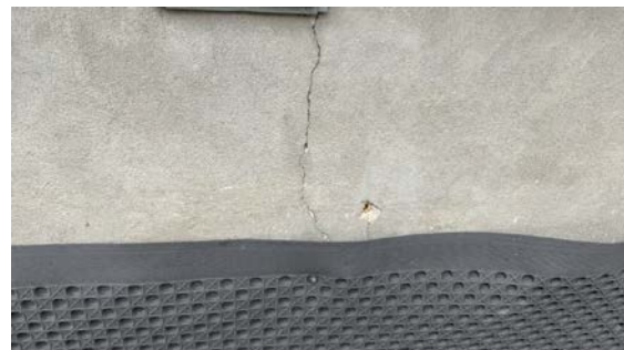
Sprekk i mur
