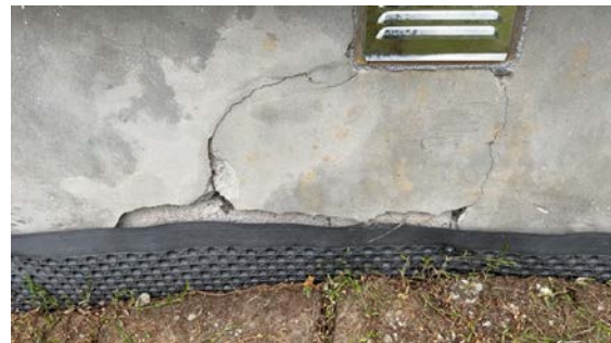
Sorekker i mur og avskalling av puss
