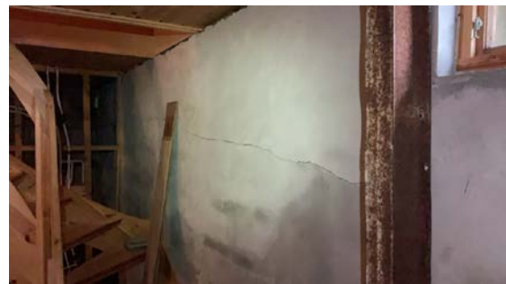
Sorekker i mur og avskalling av puss
