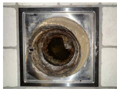
Originalt sluk i støpejern
