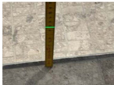
Fallforhold ca. 117 mm overkant gulv ved dusjsone
