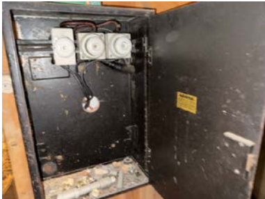
Sikringsskap hovedsikring
