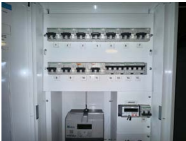
Sikringsskap hovedsikring
