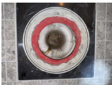
Plastsluk med klemring og synlig membran/mansjett
