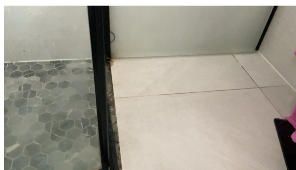
Den ene glassdøren mangler list i bunn som hindrer vann å renne ut på gulvet. List bør monteres.
