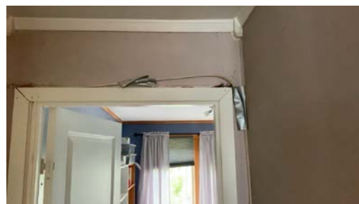
Løse ledninger festet med tape.
