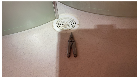
Kontroll av sluk.
