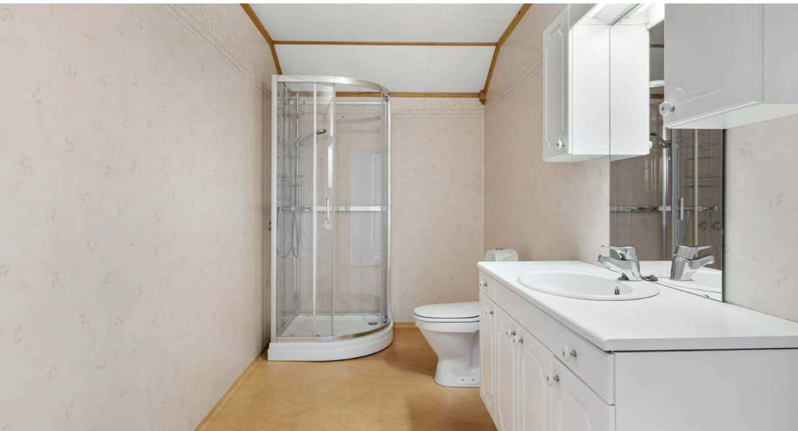
Romslig bad/vaskerom fra byggeåret 1997. Baderommet har våtromsbelgg på gulv og vegger, gulvvarme og ventil i tak med mekanisk Flexit loftsvifte.
