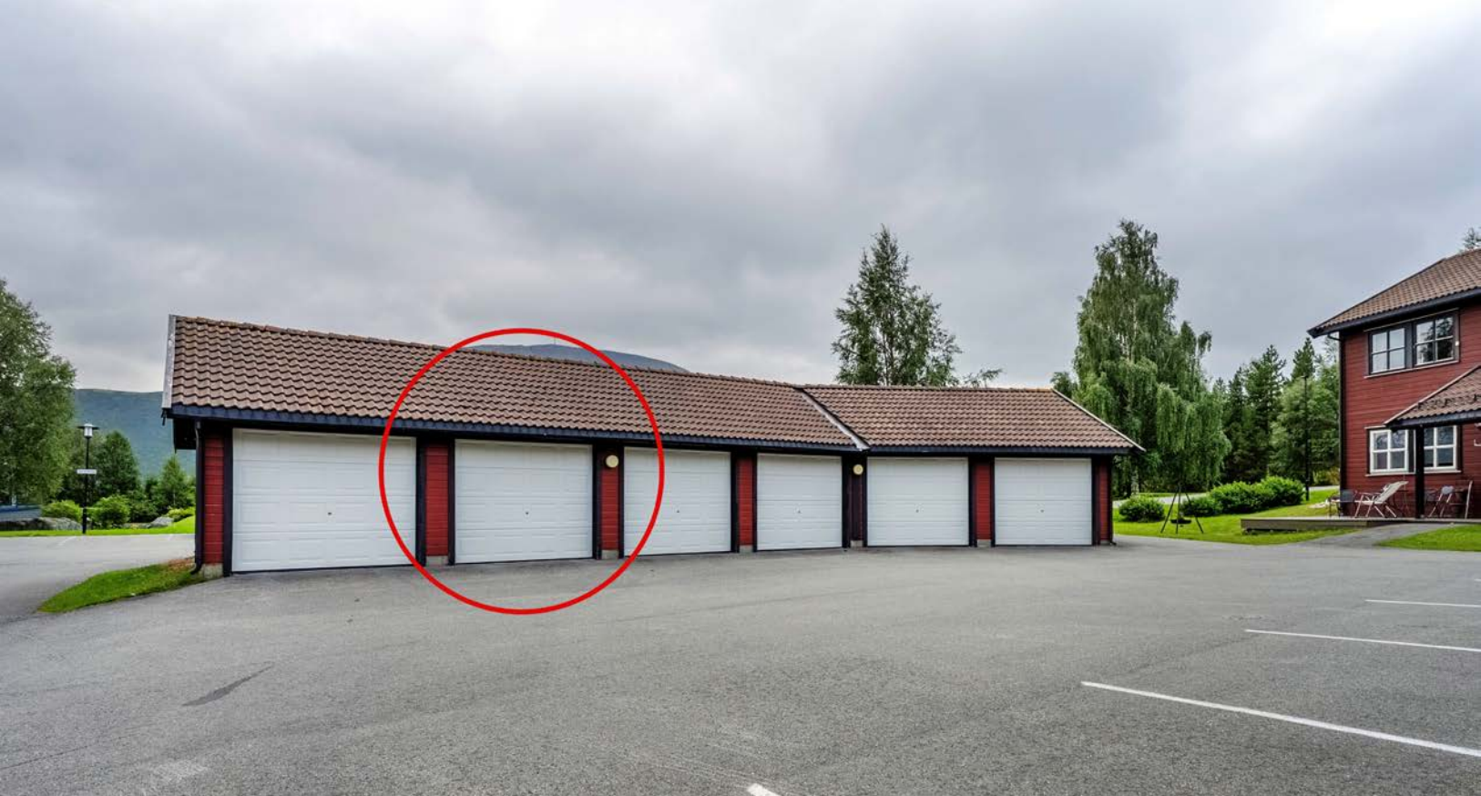
Boligen har garasjeplass i felles garasjerekke inne på tunet
