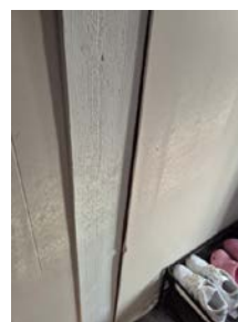
Plate i gang som ikke er tilstrekkelig festet.
