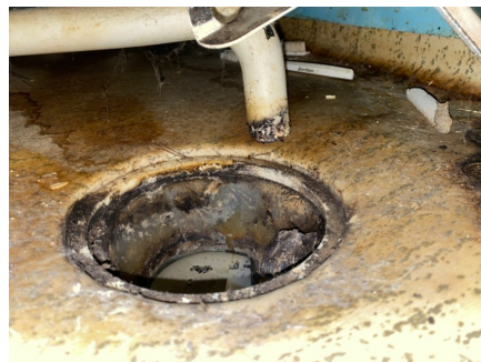
Plastsluk, og vinylbelegg er synlig ført under slukets klemring.
