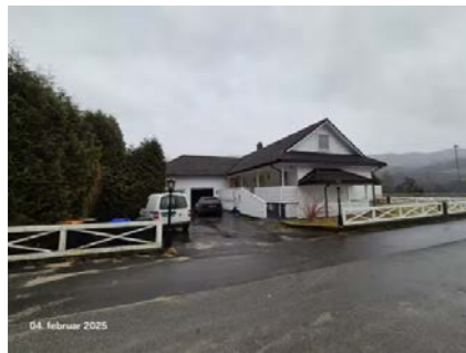
Oversiktsbilde av tak tatt fra bakkenivå.
