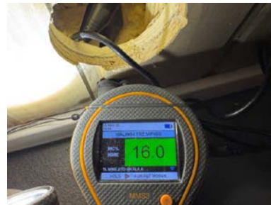
Fuktsøk med måleprobe i konstruksjon
