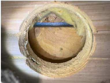
Hulltaking i tilstøtende entré
