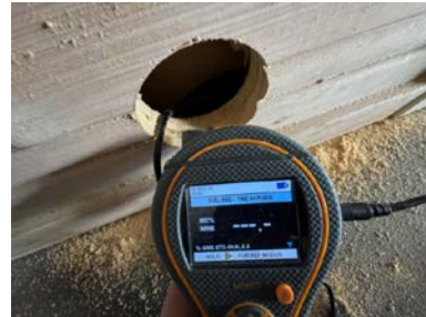
Hulltaking i tilstøtende entré
