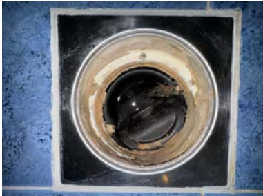
Plastsluk med klemring og synlig membran/mansjett
