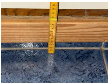
Fallforhold ca. 105 mm overkant gulv ved terskel
