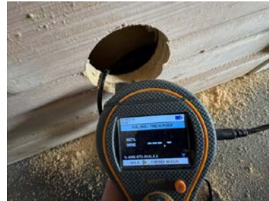
Hulltaking i tilstøtende entré
