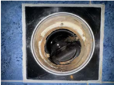
Plasts luk med klemring og synlig membran/mansjett
