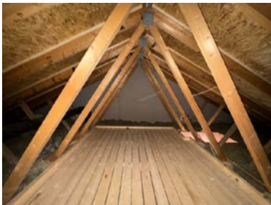
Takkonstruksjon og kaldtloft
