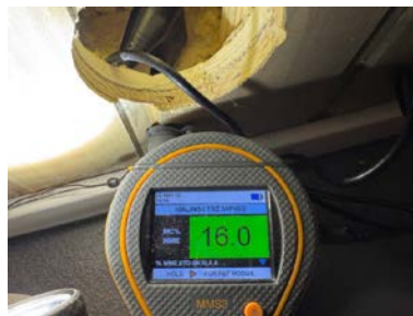
Fuktsøk med måleprobe i konstruksjon
