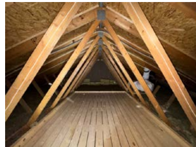
Takkonstruksjon og kaldtloft
