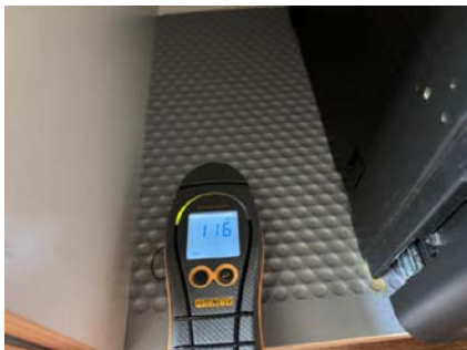
Ingen forhøyede fuktverdier ble registrert i kjøkkenbenken.
