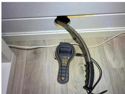
Hulltaking fra soverom mot sør.
