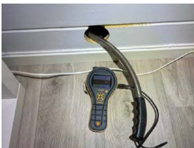
Hulltaking fra soverom mot sør.
