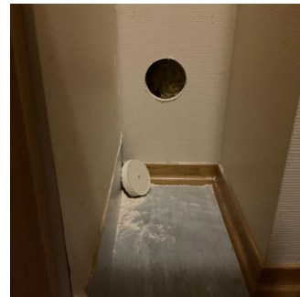
Fuktindikator angir normale fuktverdier i isolasjon og trematerialer i Hultaking i veggplate på bod skillevegg.
