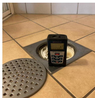
Målt høyde ved sluk _ ok høydeforskjell til terskel
