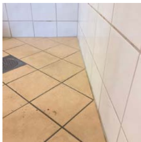
Felt langs vegg hvor det er ujevn overgang flis. Hul lyd under flis ved et lite område.
