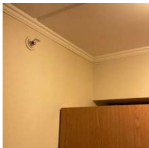
Eksempel på dyse for sprinkleranlegg
