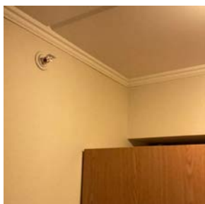
Dyse med ampull for sprinkleranlegg
