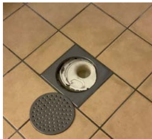
Sluk av plast _ med kopp til å trekke opp for rens
