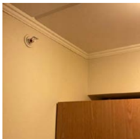
Eksempel på dyse for sprinkleranlegg
