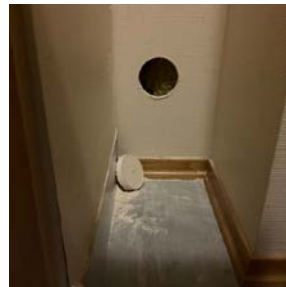
Fuktindikator angir normale fuktverdier i isolasjon og trematerialer i skillevegg.
