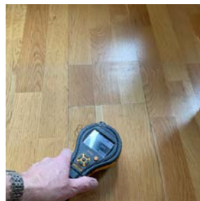
Normale fuktverdier ved område hvor det er fuktskjolder
