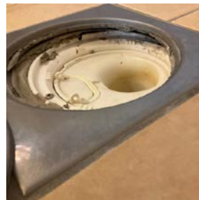
Sluk av plast _ med kopp til å trekke opp for rens
