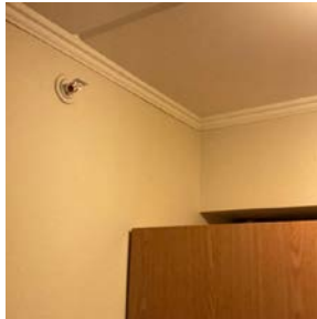
Dyse med ampull for sprinkleranlegg
