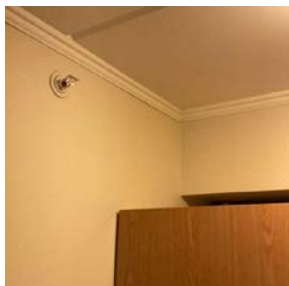
Eksempel på dyse for sprinkleranlegg
