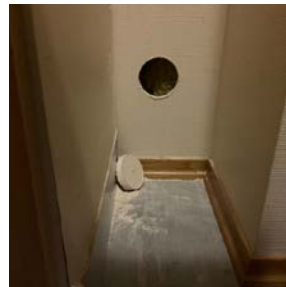
Hulltaking i veggplate på bod
