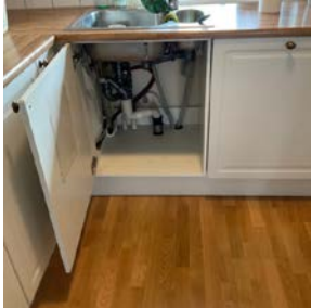
Røropplegg i kjøkkenbenk _ stengeventil _ varmtvannsbereder
