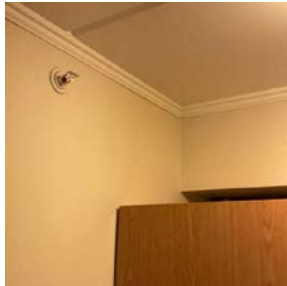
Dyse med ampull for sprinkleranlegg
