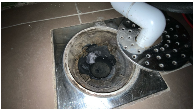
Kontroll av sluk.
