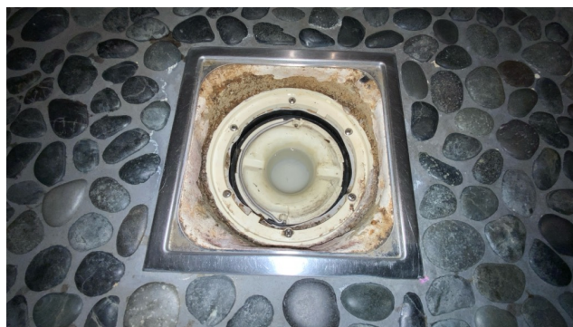
Kontroll av sluk.
