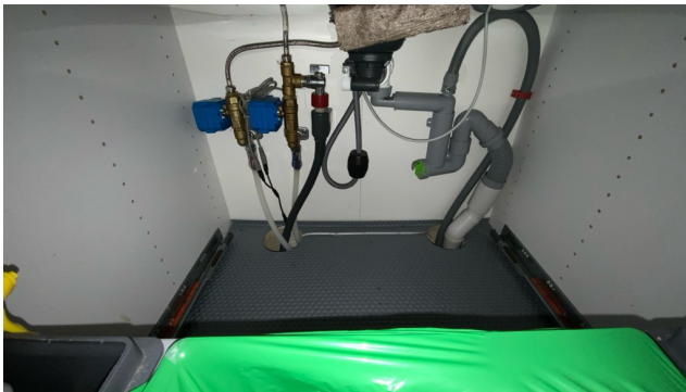
Besiktigelse av røropplegg.
