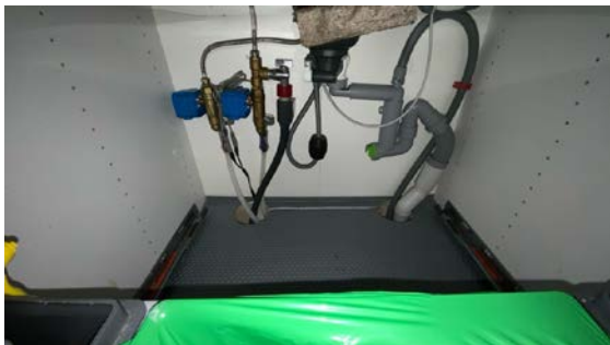
Besiktigelse av røropplegg.
