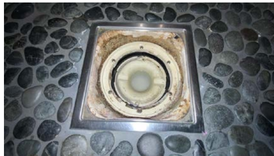
Kontroll av sluk.
