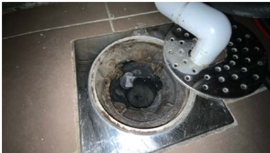
Kontroll av sluk.
